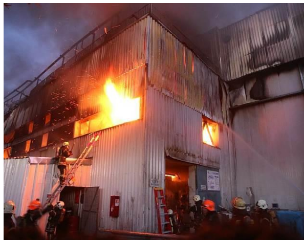
Figura N°71. Incendio en sector de Planta AquaChile (Abril 2014)
