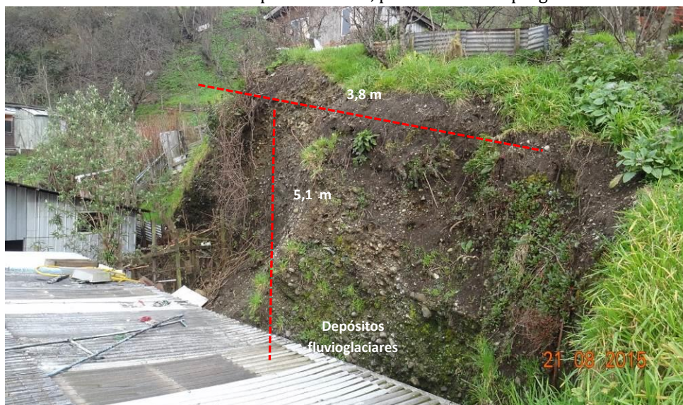
Figura N° 49. Deslizamiento rotacional con desprendimiento, población Ebensperger.
