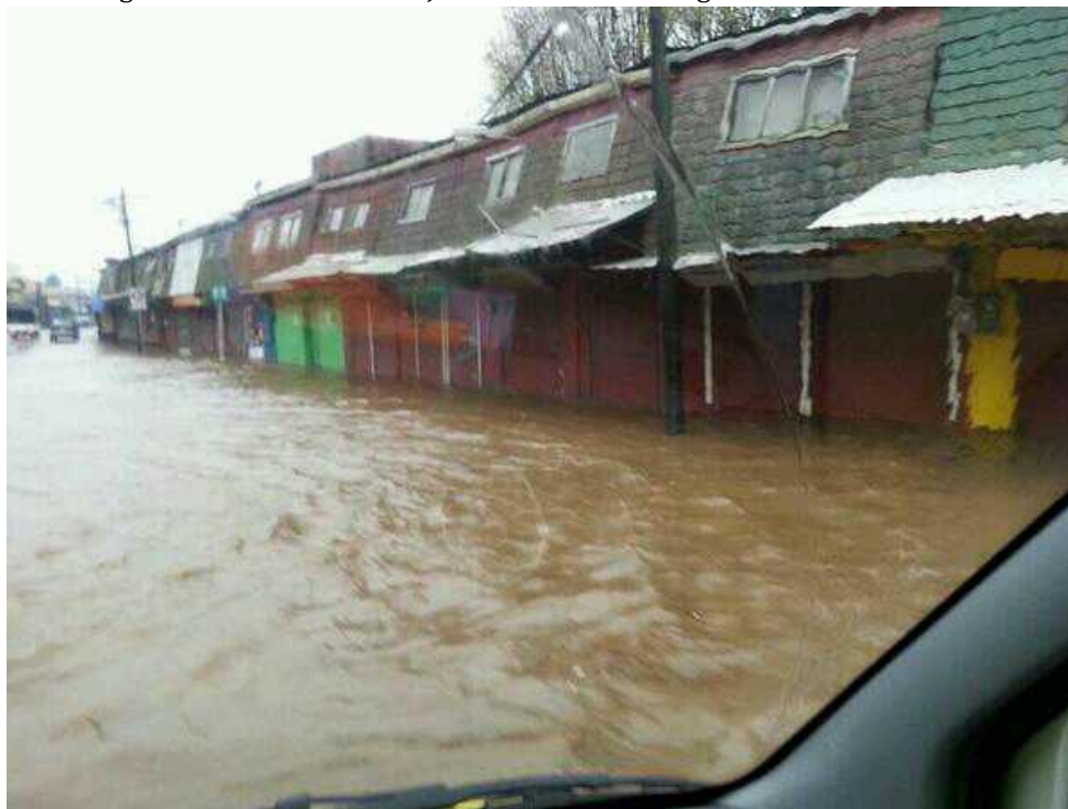
Figura N°29. Anegamientos Puerto Montt Junio 2014: Sector Angelmó.
